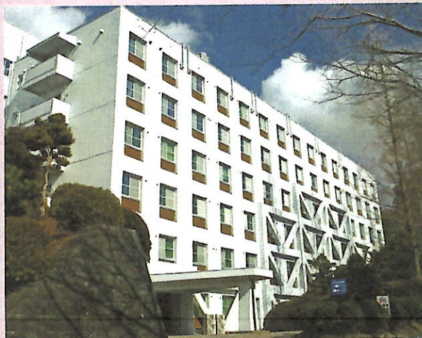
改修工事の済んだ人文社会科学部校舎/2014年 研究棟と教育棟を兼ね、大講義室やゼミ室、自習室や生協、学生の談話スペース等を完備している。
